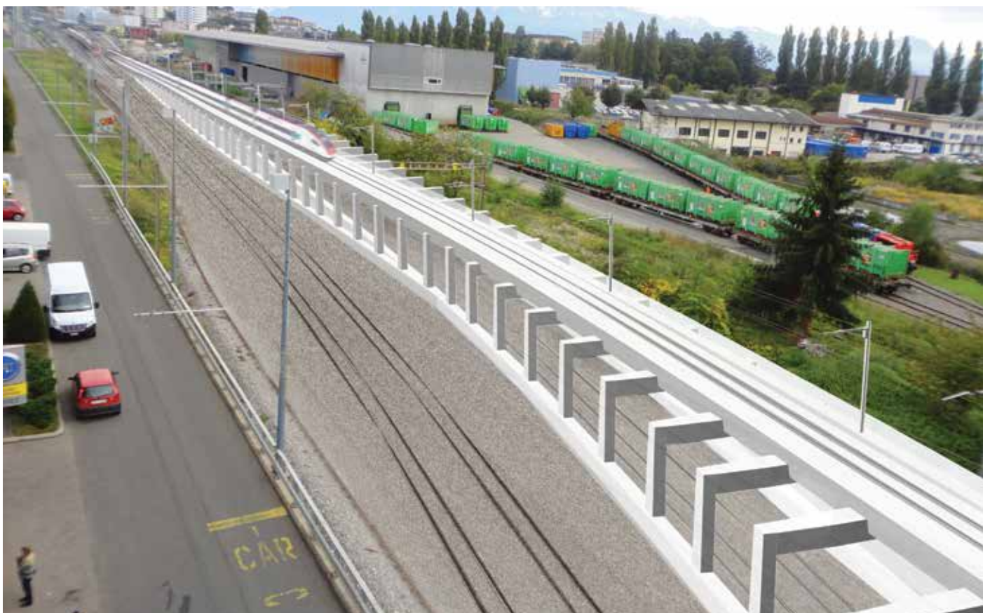
Saut-de-mouton, vue depuis le Centre Perrelet vers Lausanne, Groupement SNPR © farra & zouboulakis architectes.
